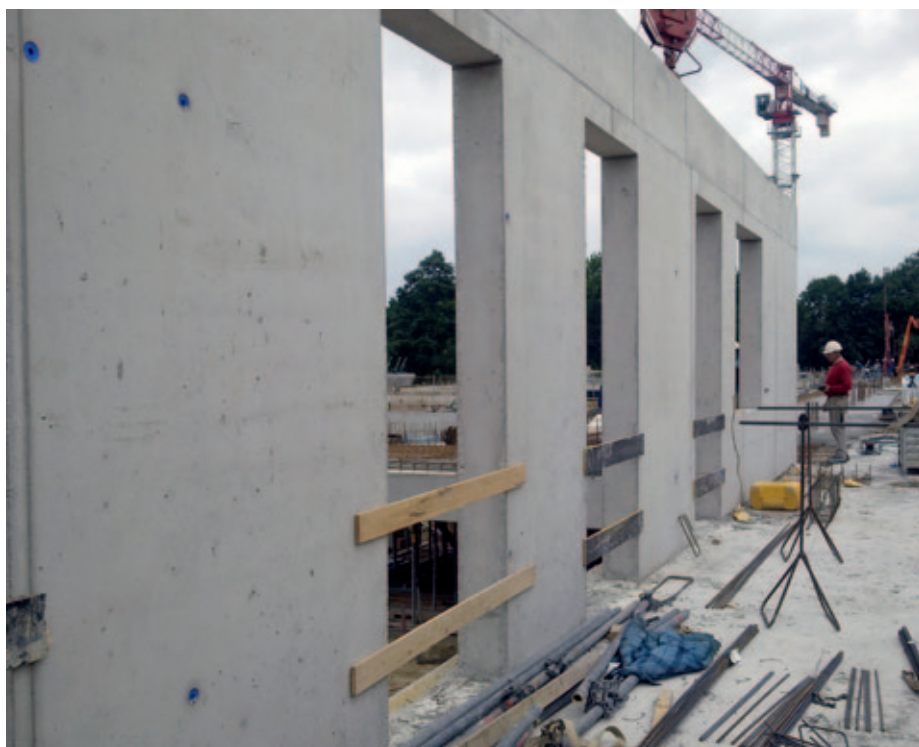
11 Betonwanden Geusseltbad op basis van 100% betongranulaat
