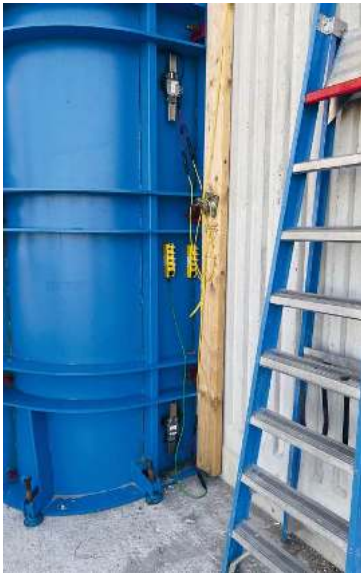
9 Bevestiging sensoren op de bekisting (foto: Aaike de Tender)
