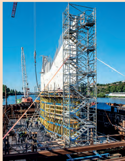
10 en 11. Bekistingswerkzaamheden aan een van de pijlers (bron: Radek Syka / Česká Doka)
