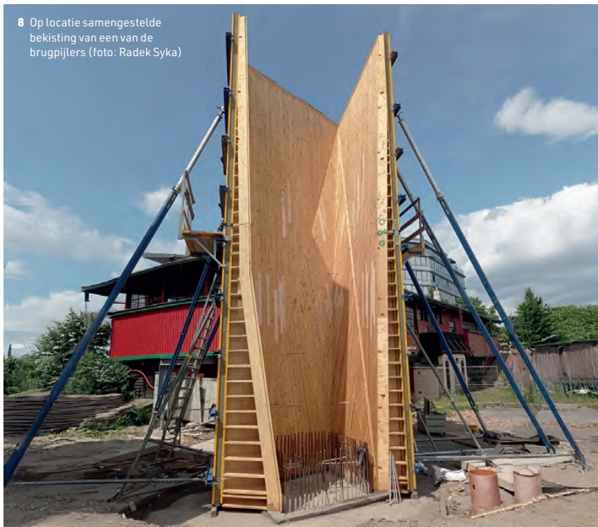
10 en 11. Bekistingswerkzaamheden aan een van de pijlers (bron: Radek Syka / Česká Doka)
