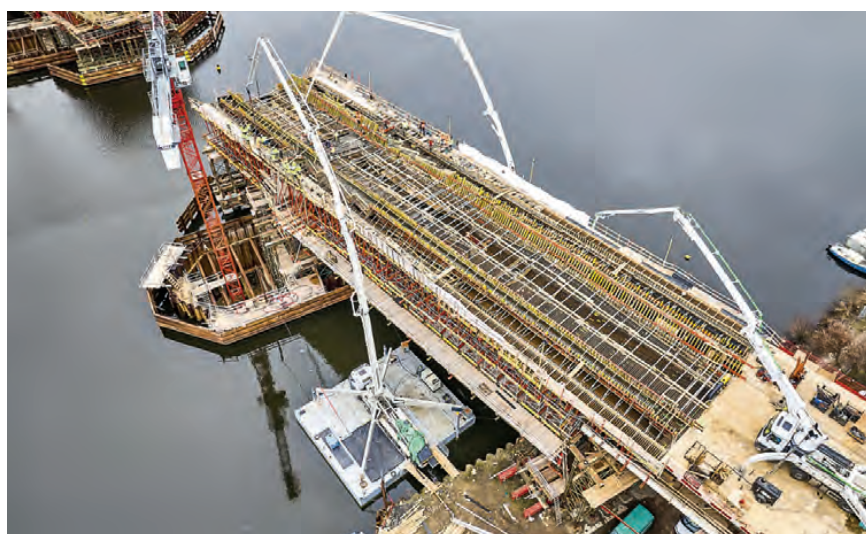
12 Pontons vormden ook een oplossing voor door pompwagens lastig te bereiken plekken (foto: Metrostav)
