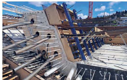
13 Doorsnede van een brugsegment met ingestorte kanalen voor verschillende leidingen en voorspankabels (foto: Česká Doka Technical department)
